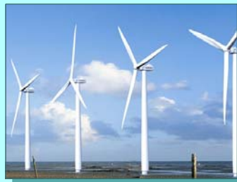
Windpark In Windkraftanlagen werden Frequenzumrichter eingesetzt, um die Spannung und Frequenz der vom drehzahlveränderlichen Rotor gewonnenen elektrischen Energie an das Versorgungsnetz anzupassen.
